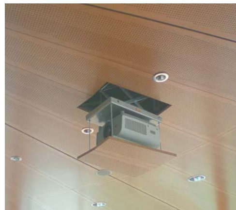
Detail Beamer Stadtwerke Bielefeld
