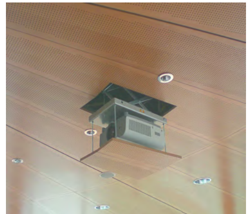
Detail Beamer Stadtwerke Bielefeld
