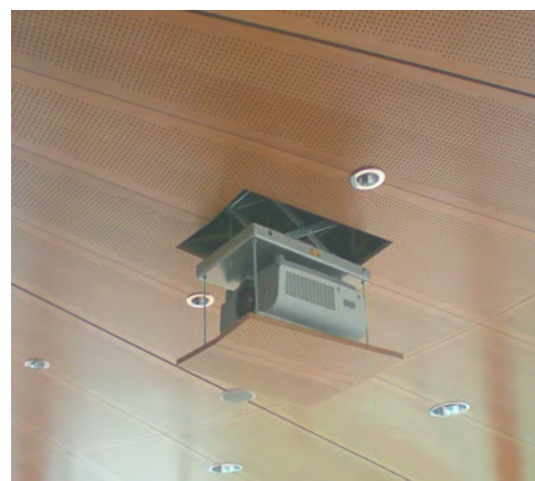
Detail Beamer Stadtwerke Bielefeld
