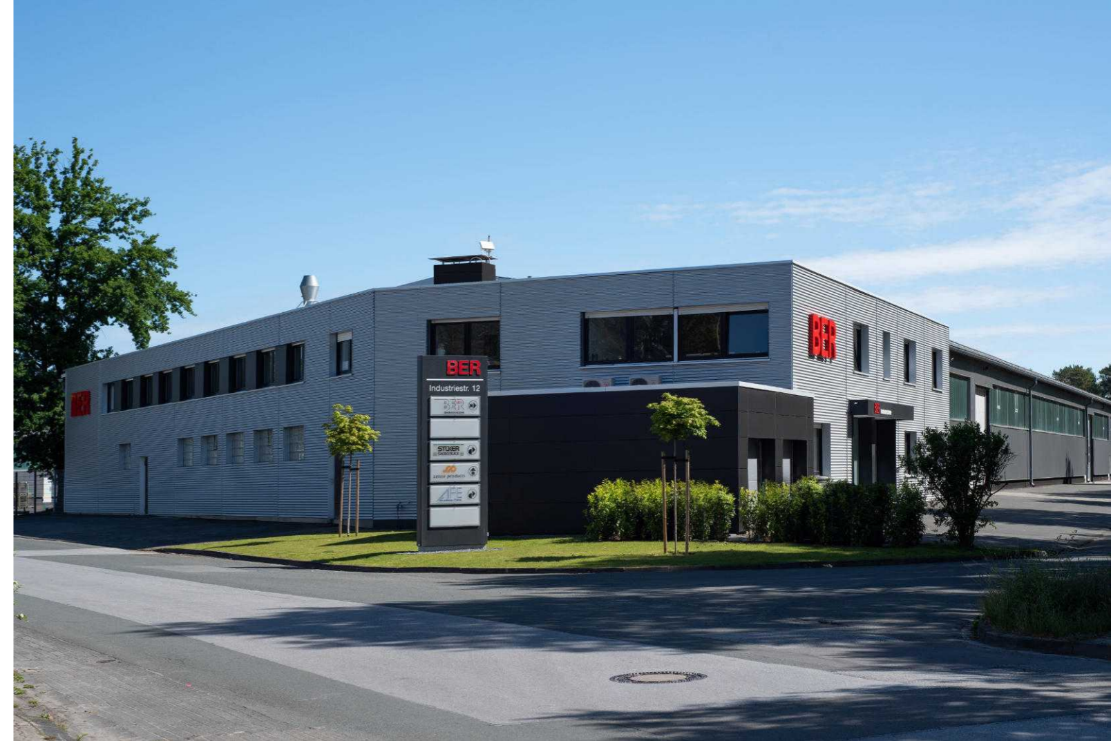
1 | Verwaltungsgebäude BER Deckensysteme, Hövelhof
