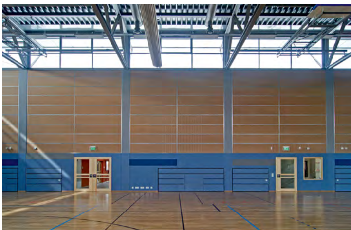
Dreifach Sporthalle am Rabet in Leipzig BER Holz-F Akustikplatte Typ ST 3-16 uneingeschränkte ballwurfsichere Wandverkleidung System W625-65 befestigt mit Hutprofil DP65 Material MDF-Oberfläche naturbelassen
