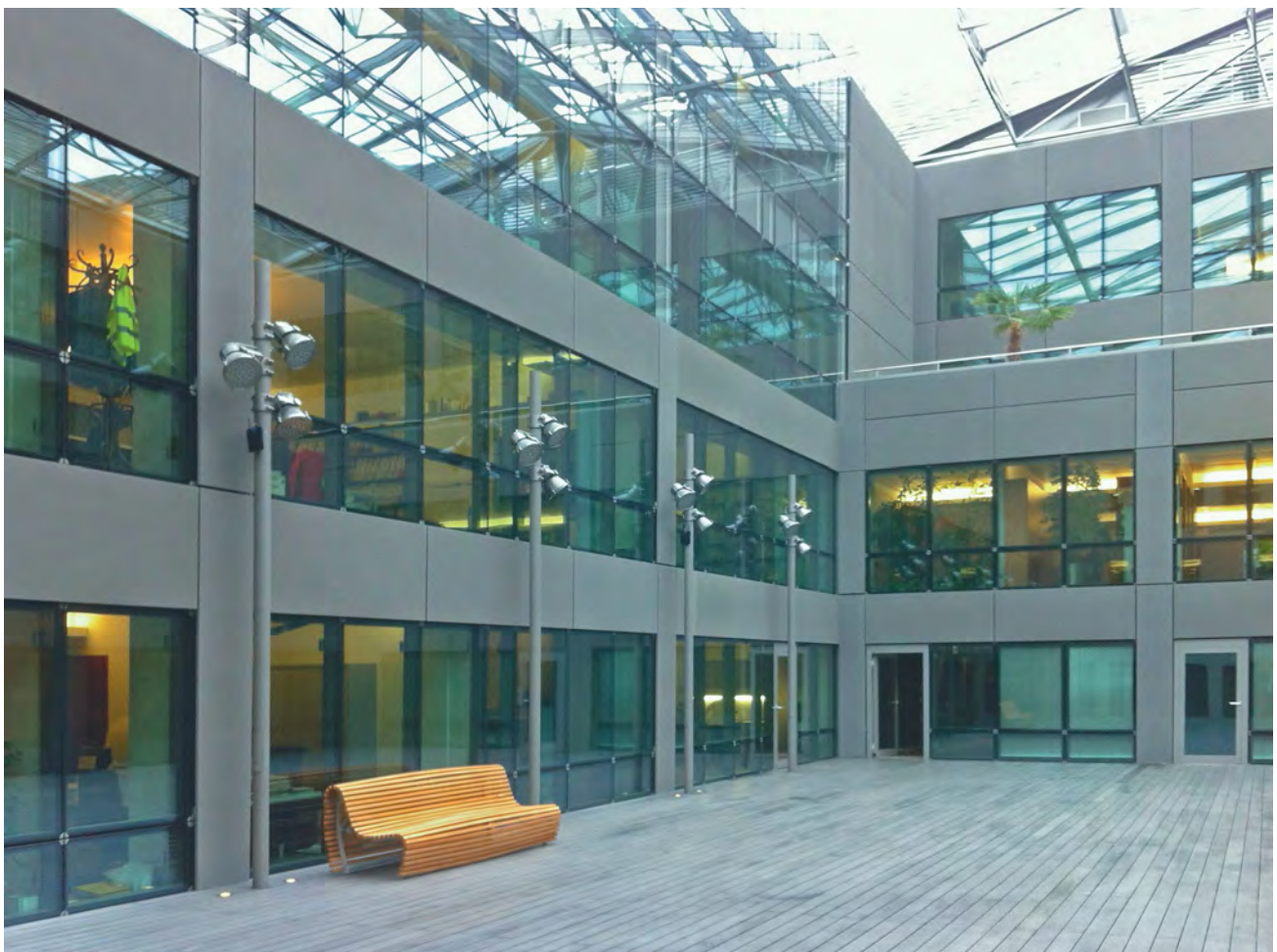
BER Metall-V Akustikplatte im überdachten Atriumhof im Sonderfarbton Graualuminium ähnlich RAL 9007
