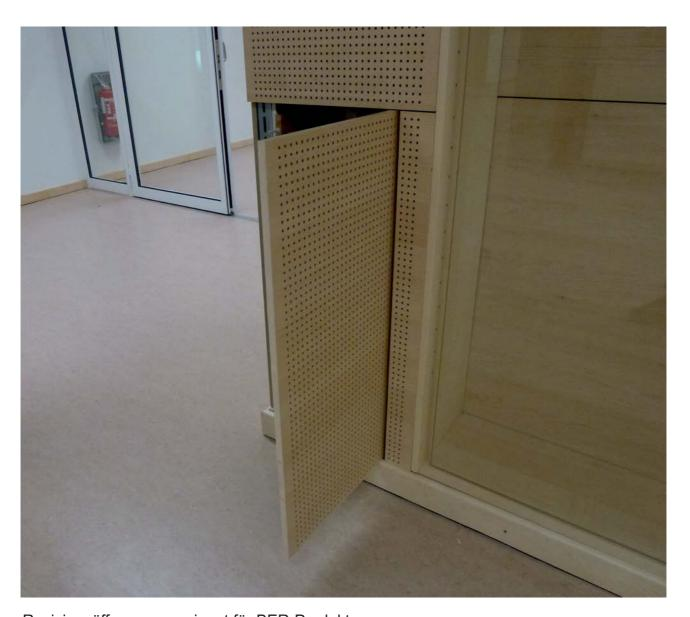
Revisionsöffnungen geeignet für BER-Produkte; Holz-F Akustikplatten Solith-G Akustikplatten Naturspan-V Akustikplatten Akupor-H Akustikplatten
