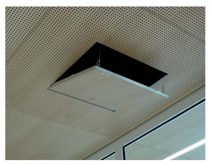
Revisionsöffnungen geeignet für BER-Produkte; Holz-F Akustikplatten Solith-G Akustikplatten Naturspan-V Akustikplatten Akupor-H Akustikplatten
