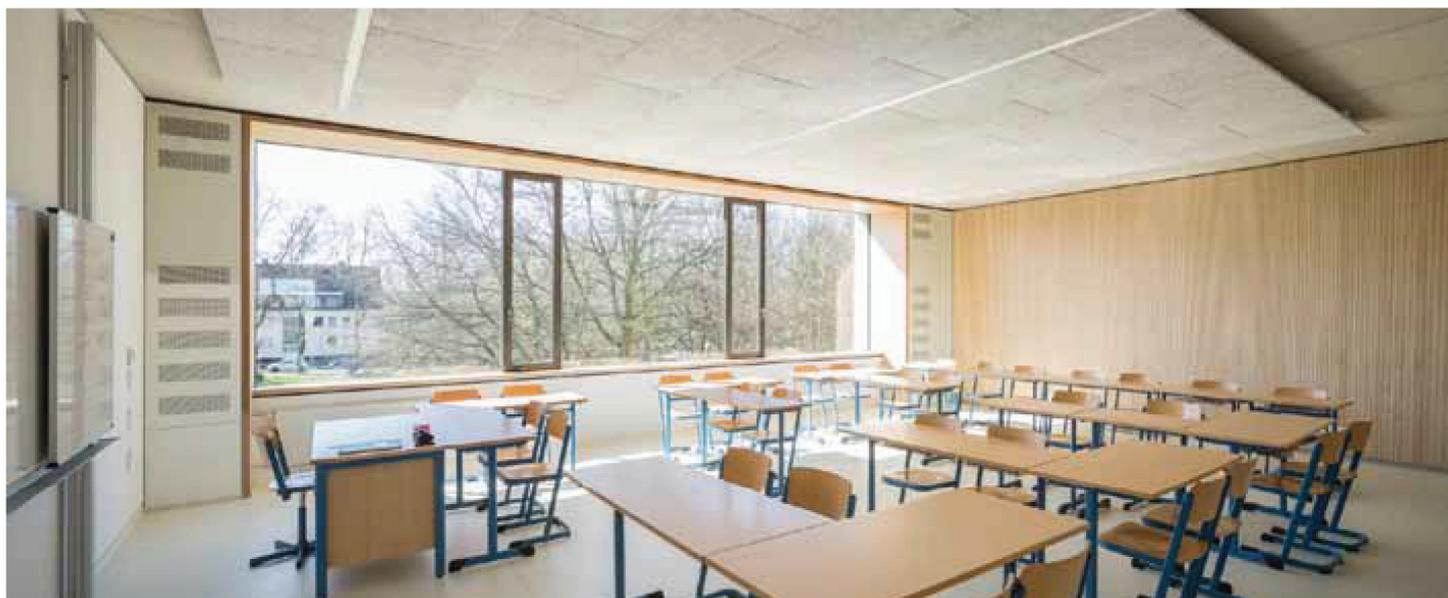
**Klassenraum.** Die geschlitzten Akustikplatten bestehen aus einer beidseitig beschichteten MDF-Platte mit einer Sichtseite in Holzfurnier und sorgen für eine optimierte Akustik an den schallharten Wänden.
