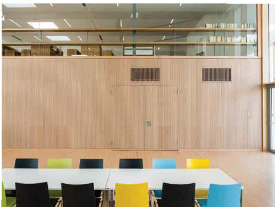
**Mensa.** In der sonst so geräuschvollen Kulisse Mensa sorgt eine Holz-F-C-DF Akustikplatte aus einer speziellen schwarzen und sehr robusten Trägerplatte für Ruhe.
