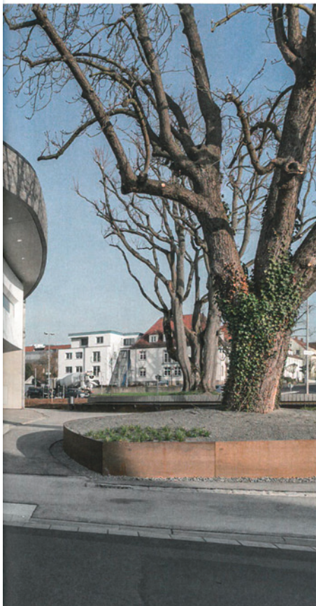
Im Norden und Osten öffnet sich die Stadthalle über eine transparente Pfosten-Riegel-Glasfassade der Umgebung.
