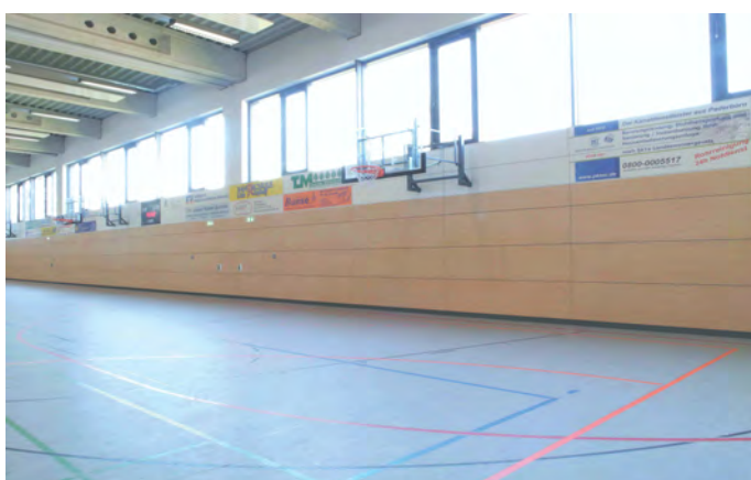
Sporthalle Borchten BER Holz-F und BER Motiv Akustikplatte Typ 6-16 als elastisches Holzprallwandsystem PW 625 einschließlich Werbefläche
