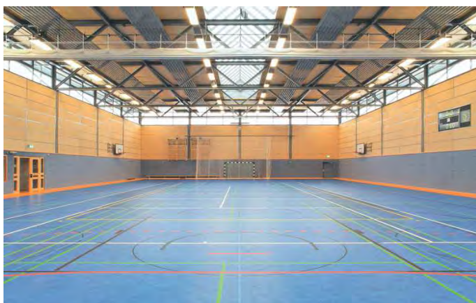
Sporthalle Uckermark Kaserne Prenzlau BER Naturspan-Akustikplatte als ballwurfsichere Wandverkleidung System W 625-65
