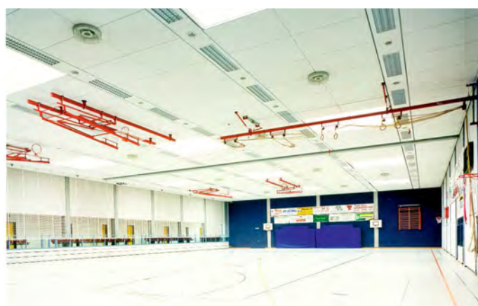
Sporthalle Thale BER Sonoplus-N Akustikplatte als ballwurfsichere Deckenverkleidung System D 1250-65-7
