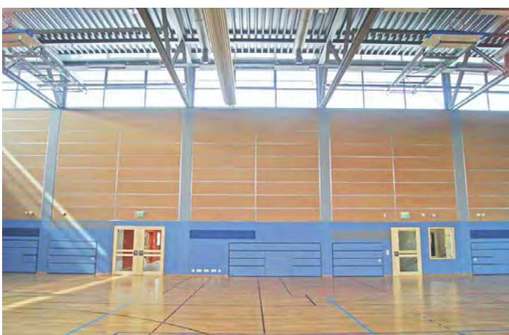
Dreifach Sporthalle am Rabat in Leipzig BER Holz-F Akustikplatte Typ ST 3-16 uneingeschränkte ballwurfsichere Wandverkleidung System W 625-65 befestigt mit Hutprofil DP65 Material MDF Oberfläche naturbelassen
