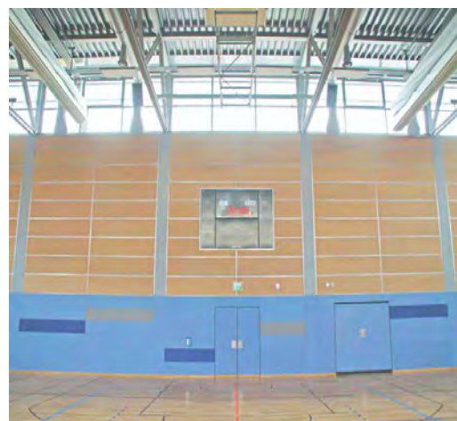
Dreifach Sporthalle am Rabat in Leipzig BER Holz-F Akustikplatte Typ ST 3-16 uneingeschränkte ballwurfsichere Wandverkleidung System W 625-65 befestigt mit Hutprofil DP65 Material MDF Oberfläche naturbelassen
