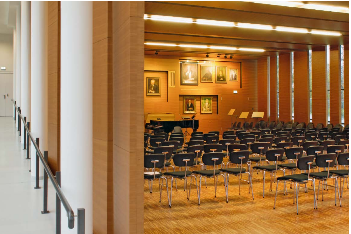
Frei stehende Zelle. Die raumseitige Fläche ist perforiert. Geschlossen hingegen ist die rückseitige, zur Glasfassade des Probensaals zeigende Halbschale, sie wirkt schallreflektierend.
