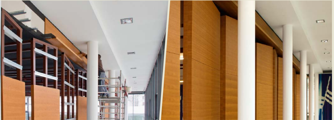
Wandverlauf. Beide Bilder zeigen, dass auch die Wandpaneele der Raumzelle nicht in einer Flucht laufen. Dadurch wird eine diffuse Schallausbreitung gefördert.
