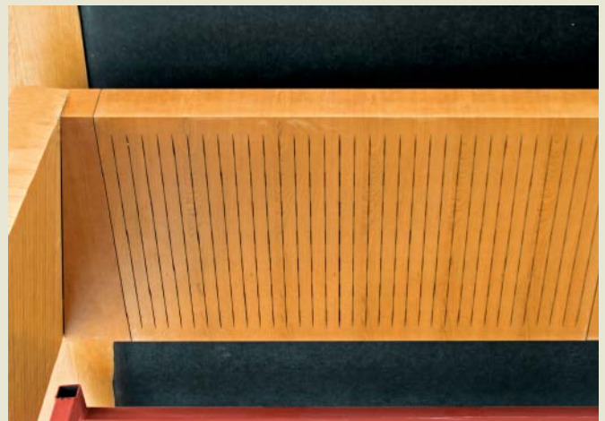
Wandanschluss. Auch hier wurde mit einem Anpasseelement gearbeitet, weil das Wandpaneel und Deckenpaneel nicht rechtwinklig zueinander stehen.
