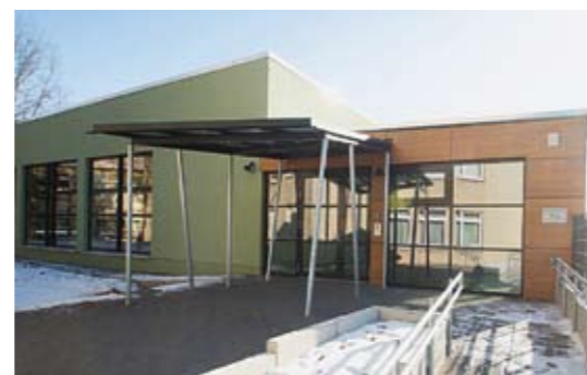
Geschwister-Scholl-Gymnasium Sangerhausen. In der neuen Halle finden nun 120 Sportstunden pro Woche statt. Baubeginn war Mitte September 2010. Die Baukosten betragen 2,86 Mio. Euro.
