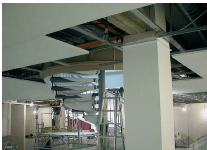
Metallakustikdecke. Ziel war es, eine optimale Sprachverständlichkeit zu sichern, selbst wenn in der Sparkasse hoher Kundenandrang herrscht. Eine Nachhallzeit von unter 0,7 s sollte daher mit dem Einbau der Ber-Akustikdecke erreicht werden.
